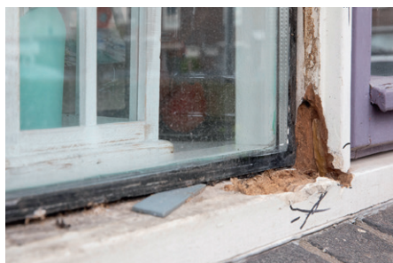
70 woningen Waddinxveen: Houtrotherstel, glasvervanging, PKVW
