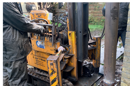
148 woningen Zoetermeer: funderingsherstel en metselwerk reparatie
